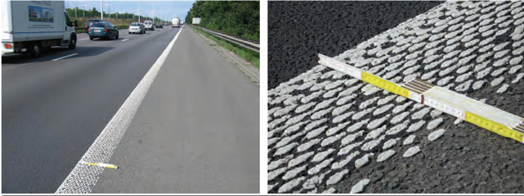
16. Measurement point MP14: E19-Vilvoorde, edge line
